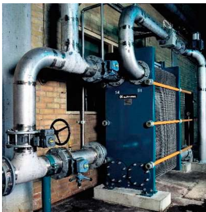
Sistema de recuperación de calor vía intercambiadores de calor Alfa Laval.
